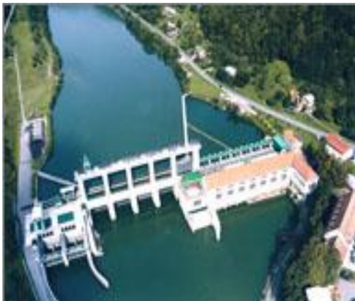
Slika 42 : Hidroelektrarna Fala – najstarejša na reki Dravi.
