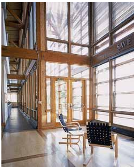
Slika 13 in 14 : Pasivni solarni sistem za ogrevanje in osvetljevanje prostorov
