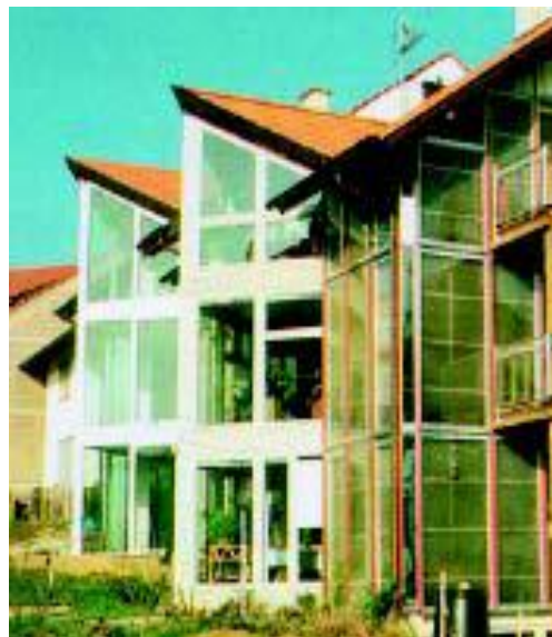
Slika 13 in 14 : Pasivni solarni sistem za ogrevanje in osvetljevanje prostorov
