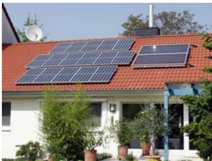
Slika 30: Sončne celice in sprejemnik sončne energije,
